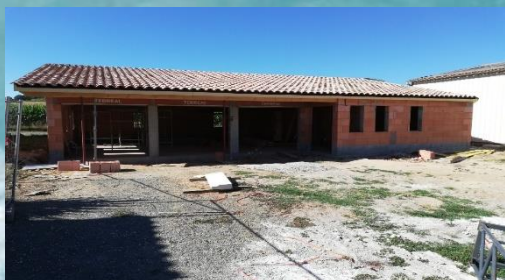
La nouvelle cantine, en travaux, depuis la route départementale.
