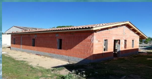
Depuis l'arrière du bâtiment.
